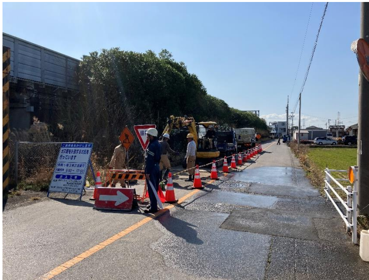
【試掘着工の様子】
