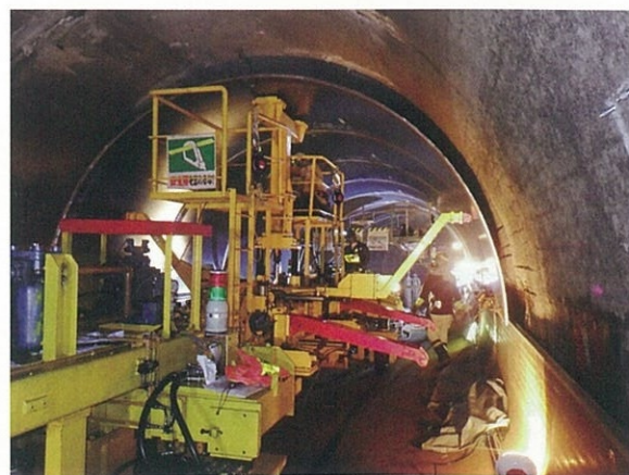
① 鋼板据付
