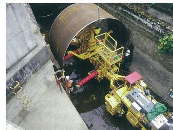
専用運搬台車による施工
