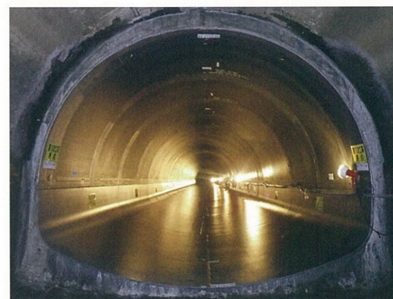
④ 工事完成
