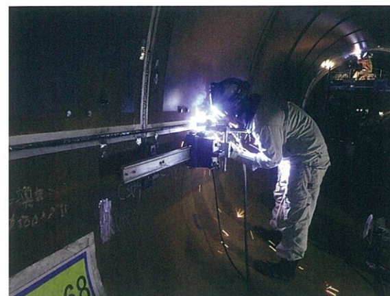
② 鋼板溶接
