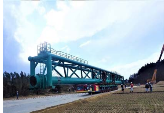
ドーリー（多軸台車）による水管橋の移動
