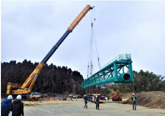
大型クレーン（550 t 級）による水管橋吊上げ
