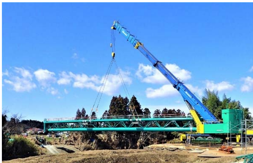
大型クレーン（550 t 級）による再架設作業
