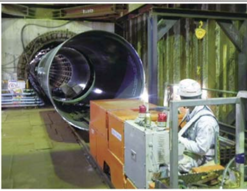
写真1 鋼管2本を運搬できるよう台車を考案
