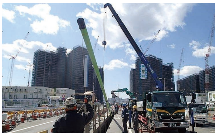
写真 水素パイプライン建設状況
