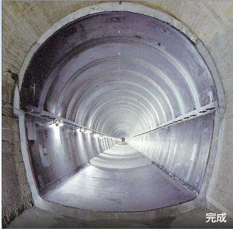
馬蹄形トンネル内巻改修工法は、老朽化した既設馬蹄形水路トンネル内に、僅かに小さい相似形断面の内巻き鋼板を、専用台車により運搬・据え付けて接合する工法であり、通水断面の減少を最小限に抑えることができる優れたトンネル改修工法です。
