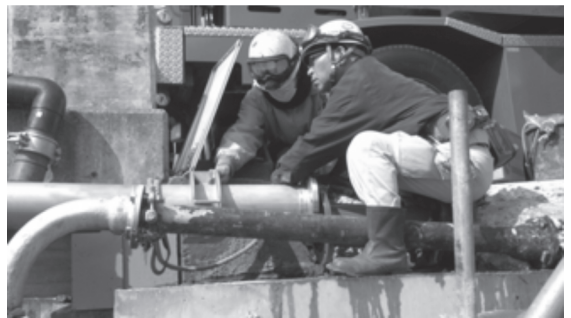
写真5 既設接続状況
