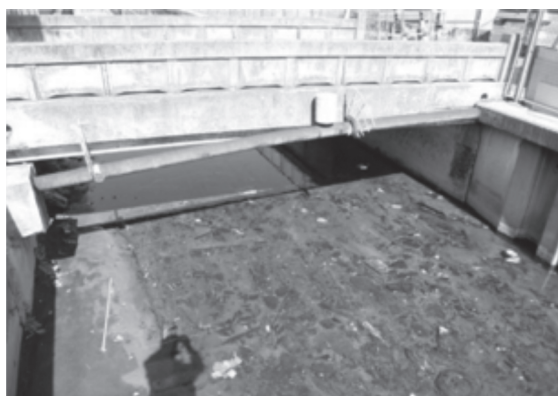
写真1 既設水管橋例
