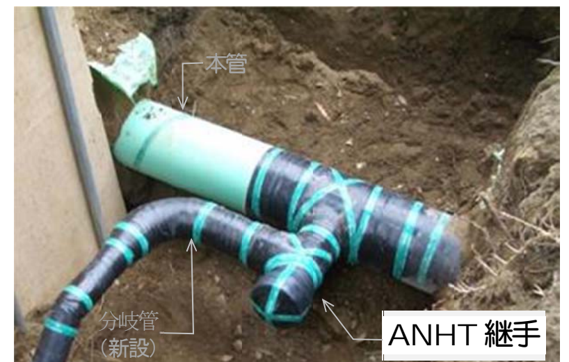
異径分岐の施工例
