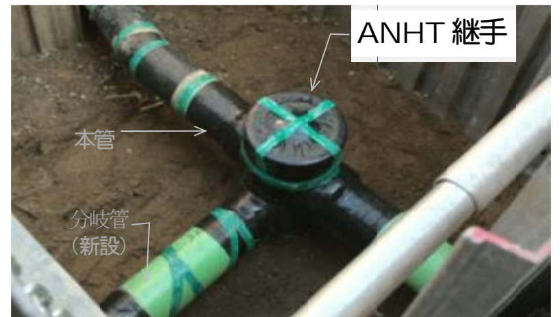
同径分岐の施工例
