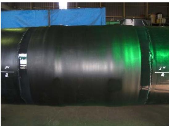
写真5 2層目熱収縮チューブ施工後外観状況
