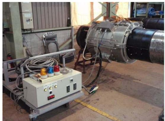
写真3 加熱施工状況
