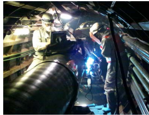
図5 シールド内溶接状況 (500A×12.7mmt X60)
