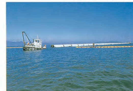
曳航する海底パイプ (浮遊曳航)
