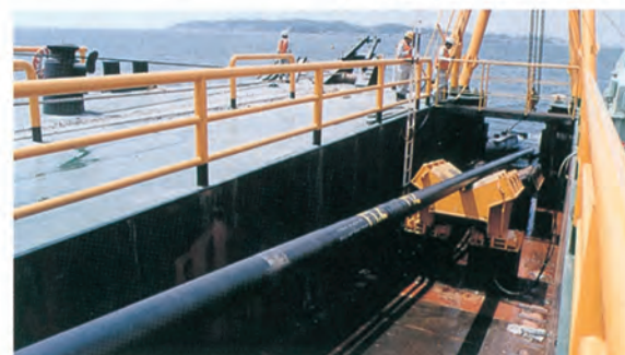
ランチング上海底パイプ
