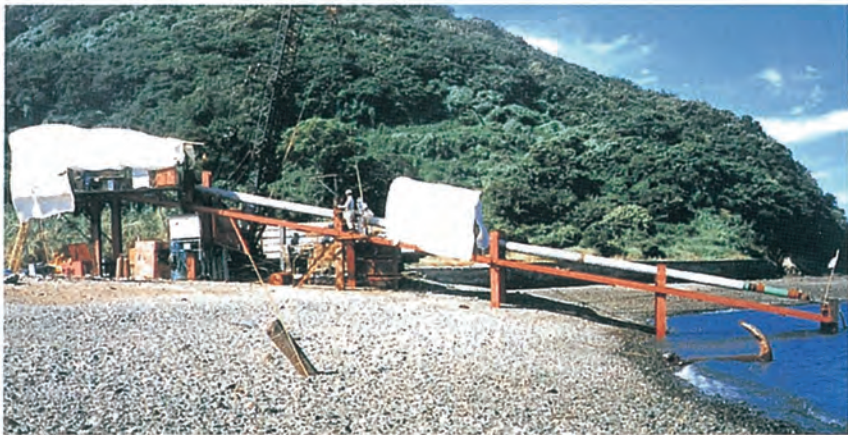
陸上ヤード(長管発進ヤード)
