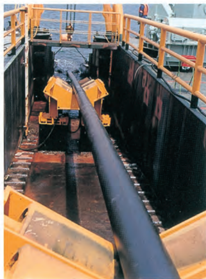
ランチング上より浸水するパイプ
