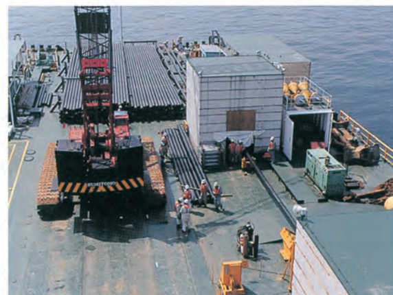
第一作業ステージ
