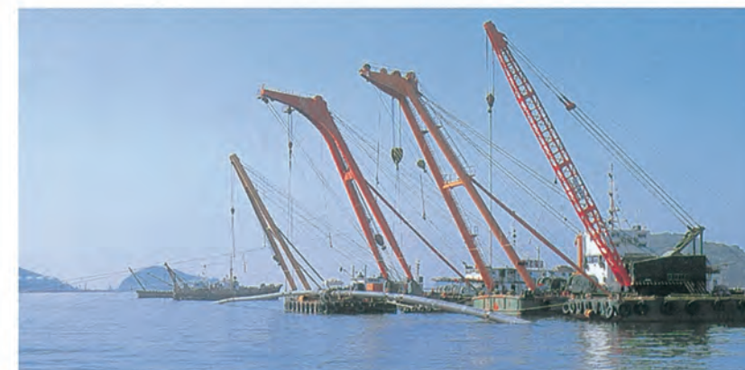
海底パイプの浮上と新設パイプの洋上溶接
