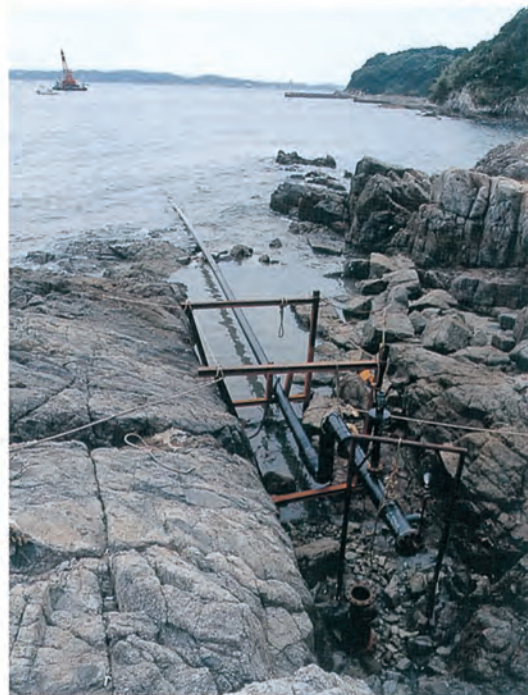
海底パイプ引込完了
