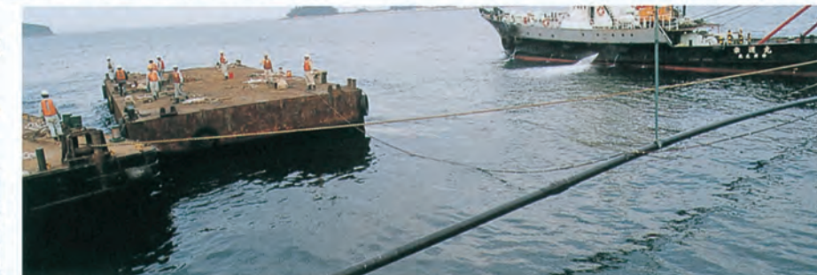
溶接接合完了の海底パイプ
