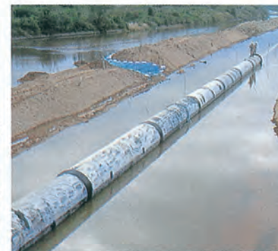
ヤードより引出されるパイプ
