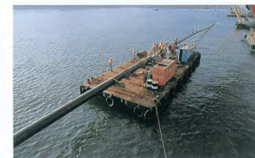
海底パイプの溶接接合台船
