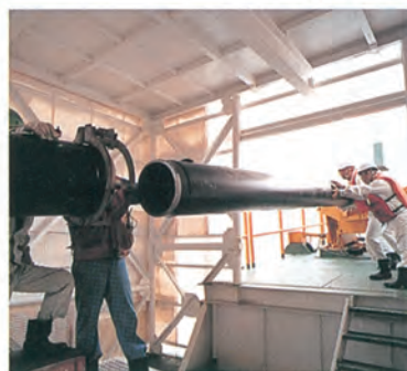
パイプの芯出し
