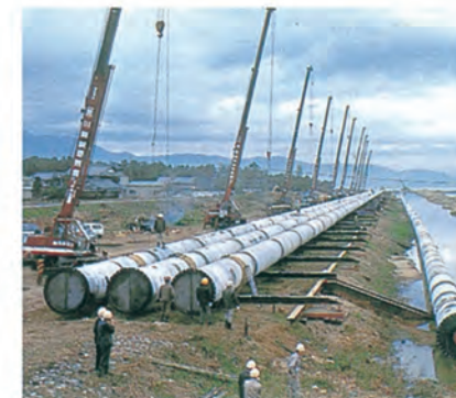
浮遊曳航用パイプのランチング
