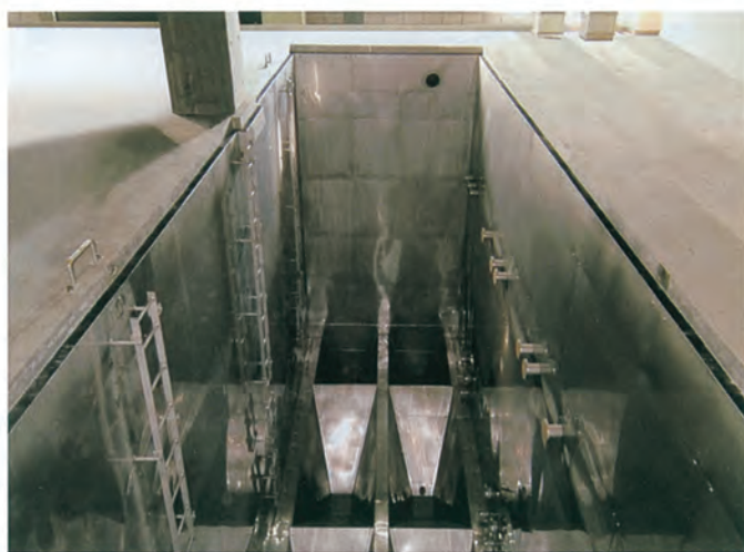
浄水場SUS内張施工例
