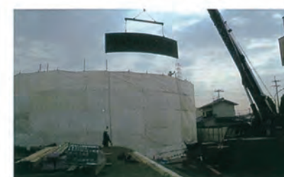
側板吊り込み
