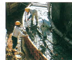
増設基礎製造
