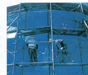
既設タンク外面塗装
