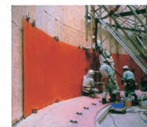
配水池内面に側板設置(1段階)
