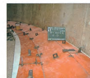
底板設置工(アニュラープレート)
