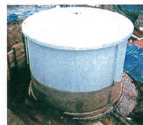
配水池周囲の掘削
