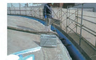
エアーモルタル打設
