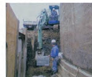
配水池周囲掘削
