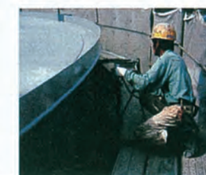
増設タンク外面塗装
