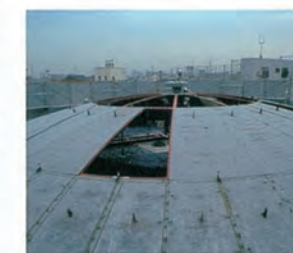
屋根板設置工
