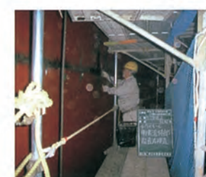
非破壊検査(側板溶接部)
