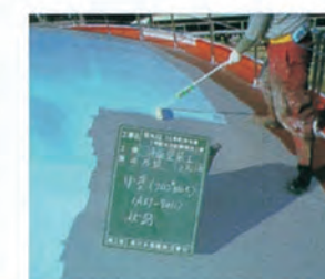
外面塗装(屋根部)
