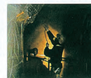
増設タンク内面塗装
