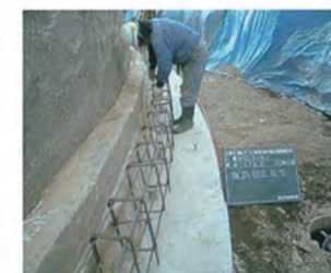
増設基礎部鉄筋組立
