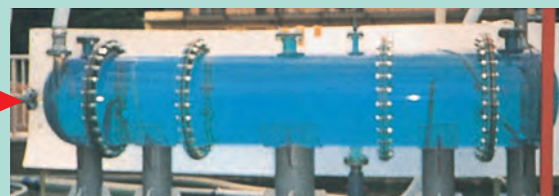
1方向の鏡板中央流入方式(2方向流入方式に比べ入れ替わり効果が劣る)
